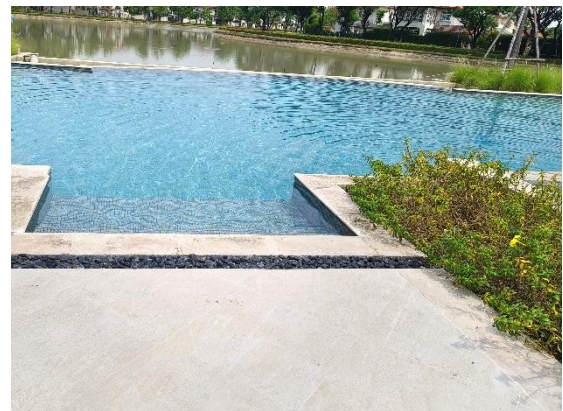
พื้นและผนังสระปูด้วยกระเบื้องเซรามิก ไม่ลื่น
